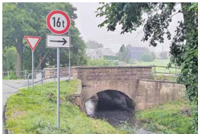
Diese Gewölbebrücke bei Hainichen wird neu gebaut.
