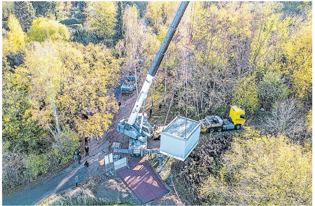
Mit Hilfe eines Krans wurde die neue Station aufgestellt.
